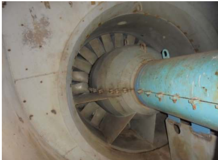
Gambar 3 Blade Primary air fan
