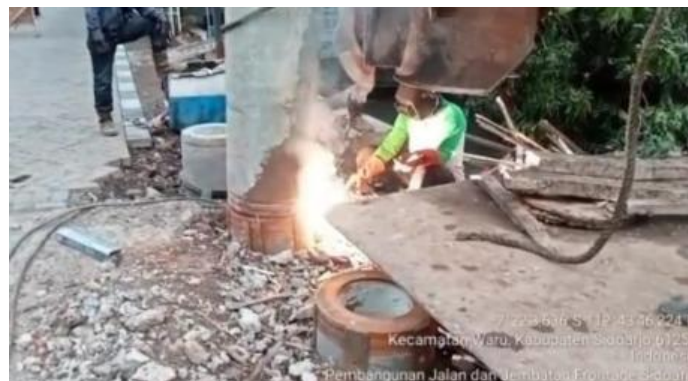
Gambar 6 Pemasangan joint plat pada spun pile existing
