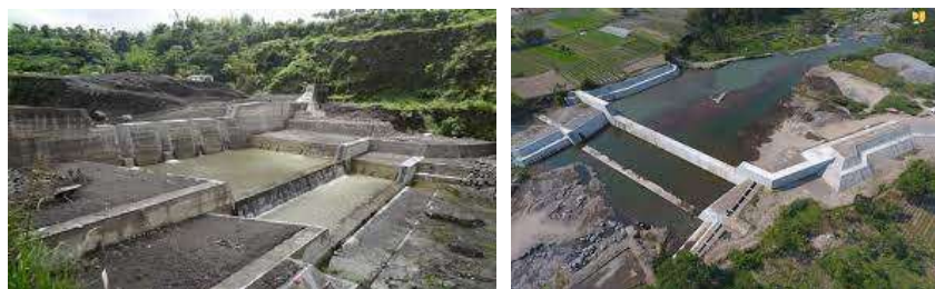
Gambar 7. Bangunan Sabo di Gunung Semeru (Kementerian PUPR, 2012)
