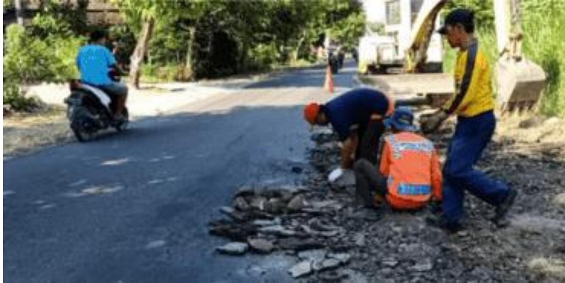
Gambar 1 Perbaikan Kerusakan Ruas Jalan Parang-Lembeyan
